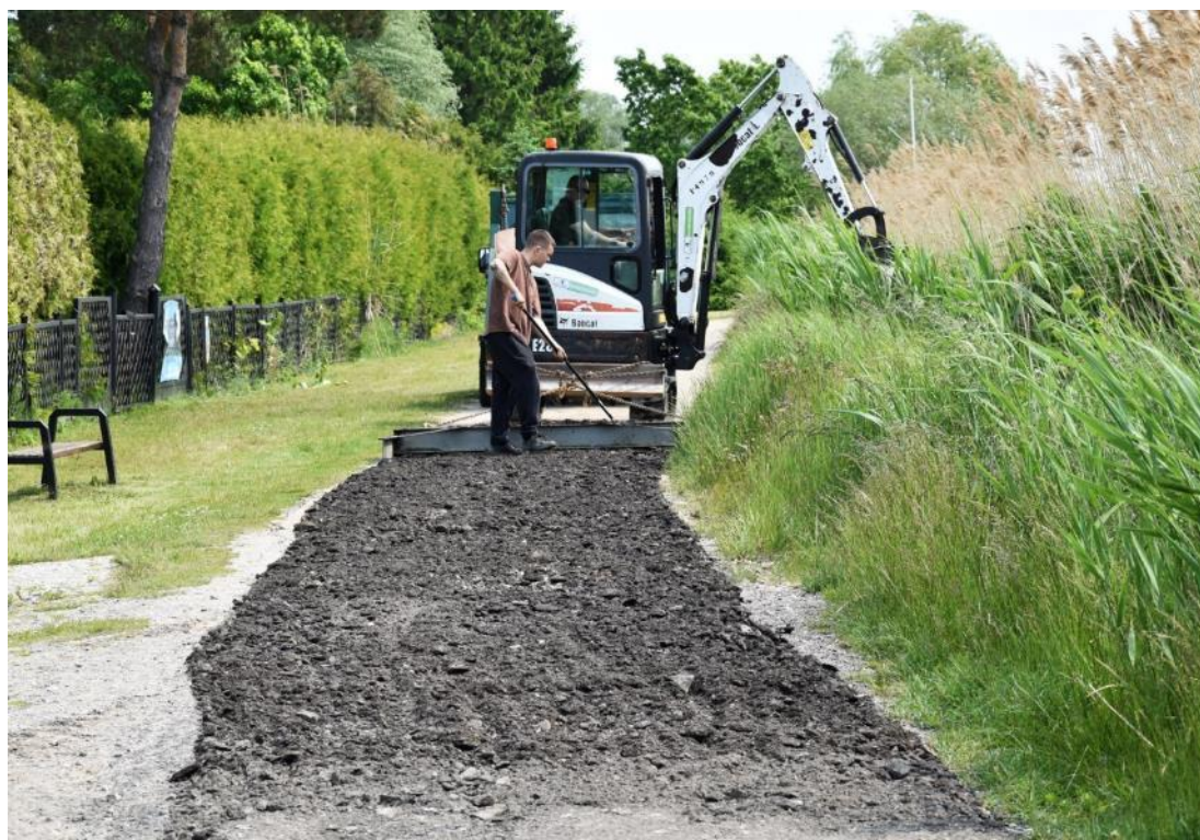
Prace wykonane w maju 2025 r. przez gminę Mielno w celu poprawy jakości najgorszego odcinka. Trwa proces przygotowania dokumentacji dla nowej nawierzchni asfaltowej.
