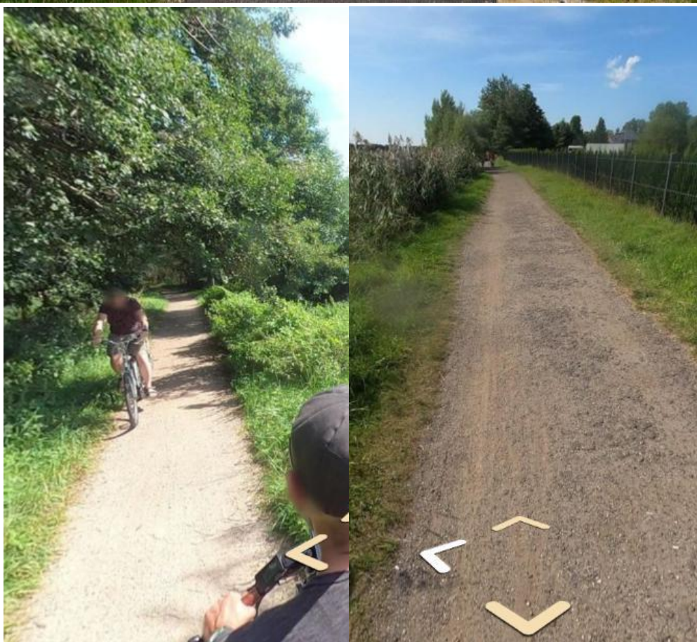
Droga o słabej nawierzchni nad Jeziorem Jamno
