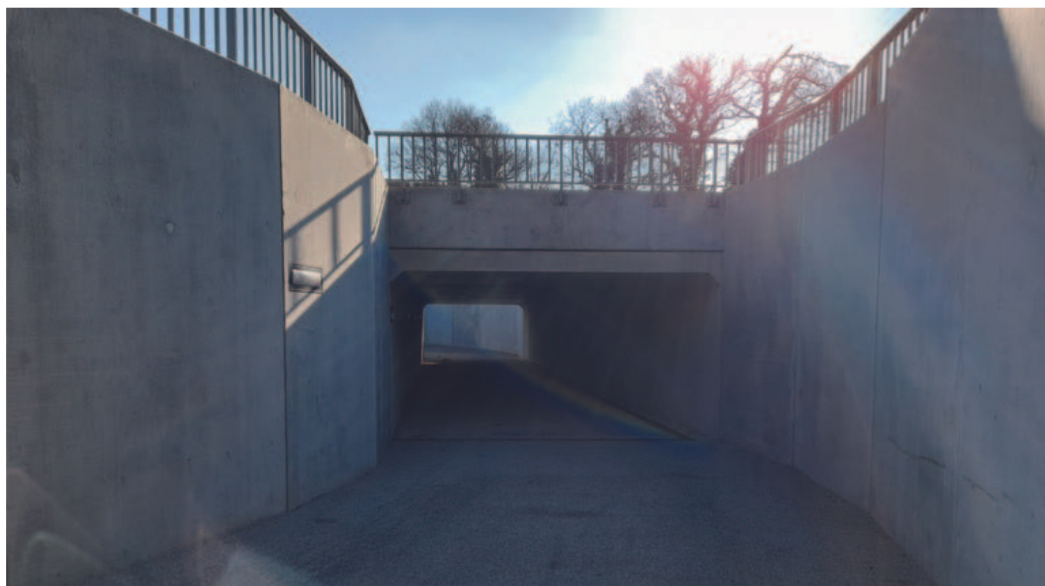
Przejazd podziemny - otwarty i jasny An open & bright underpass
